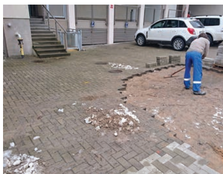
Betona bruģakmens remontdarbi
