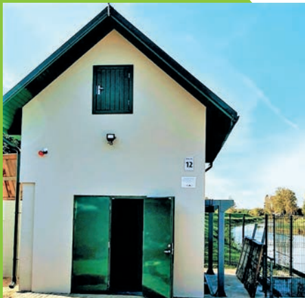
● Atklāta jaunā sūkņu stacija Kārķu ielā 12.
