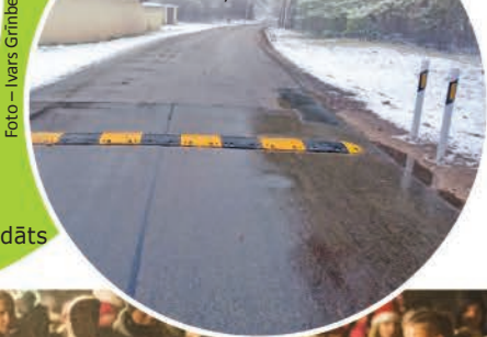
▼ Atjaunoti trīs ātrumvaļņi Alderu ielā, Alderos.
